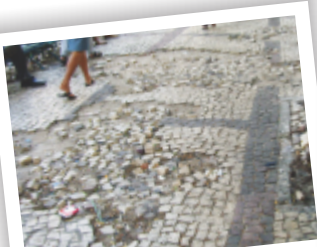
Calçadas em condições precárias de execução ou manutenção, com buracos, pedras e pisos soltos;
