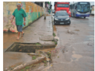
Saída de água pluvial, fossas e sumidouros sobre a calçada;
