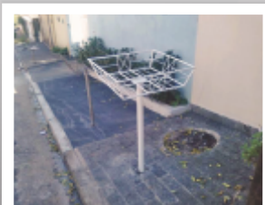
Mobiliário urbano mal localizado;
