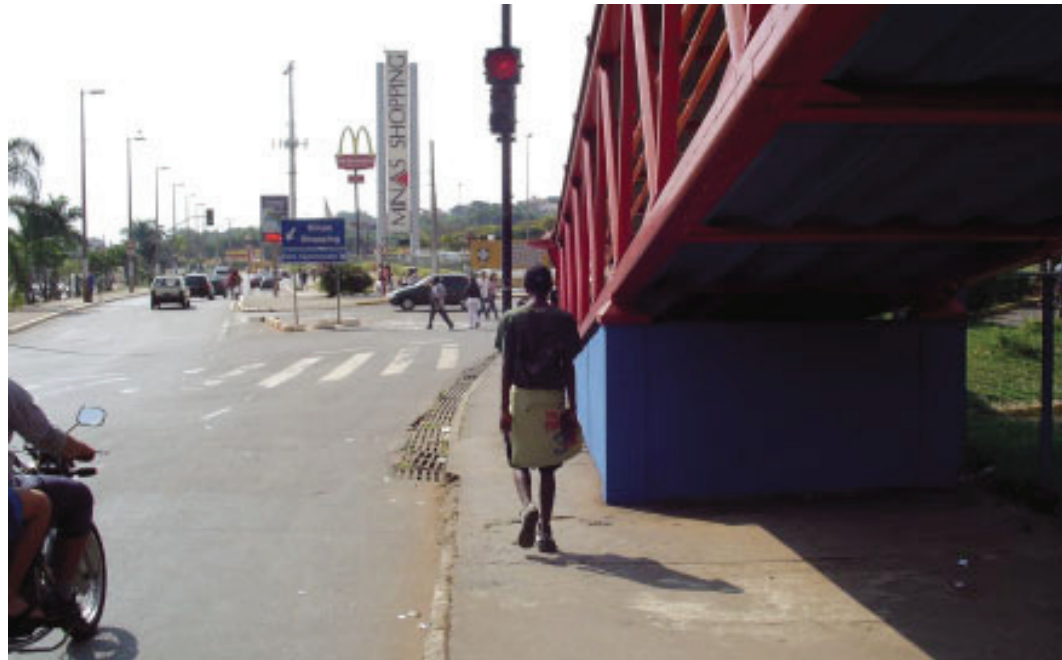
Foto 28 - Passarela de Pedestres sem Sinalização - Trecho com Altura < 2,10m
