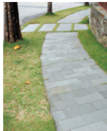
Foto 5 - Calçada com material escorregadio, proibido pelo Código de Posturas do Município de Belo Horizonte.
