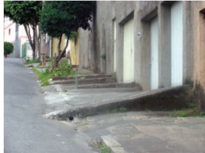
Foto 7 - Degraus na calçada impedindo o percurso, principalmente, de pessoas com deficiência física.
