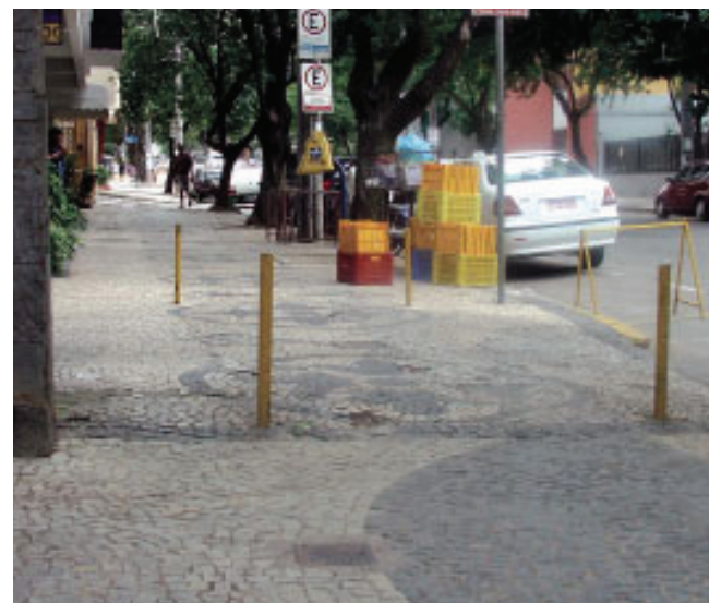
Foto 19 - Postes Metálicos e Balizadores
