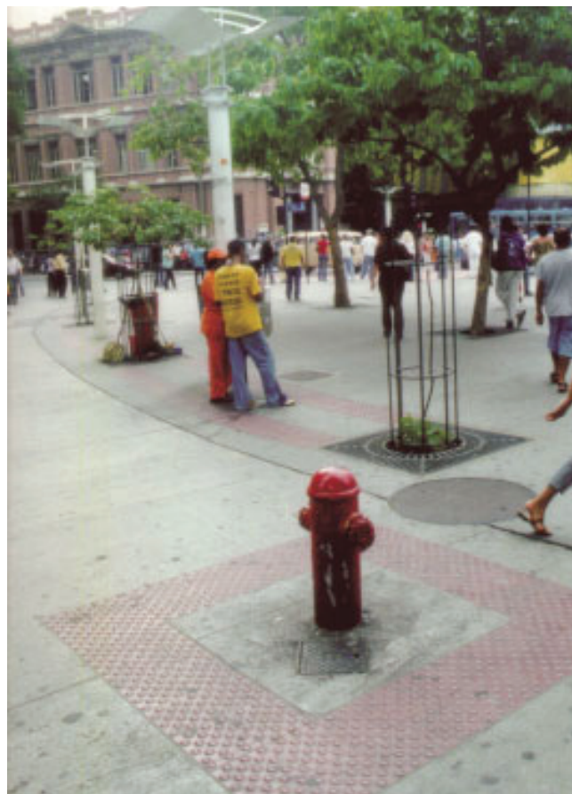
Foto 3 - Hidrante Sinalizado com Piso Tátil de Alerta
