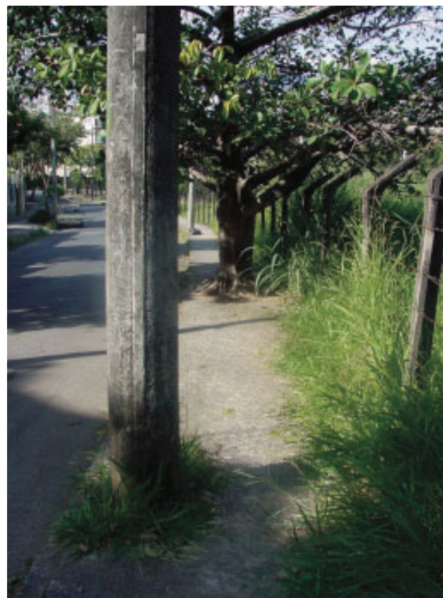
Foto 12 - Calçada estreita impedindo a circulação, principalmente, de pessoas em cadeira de rodas.
