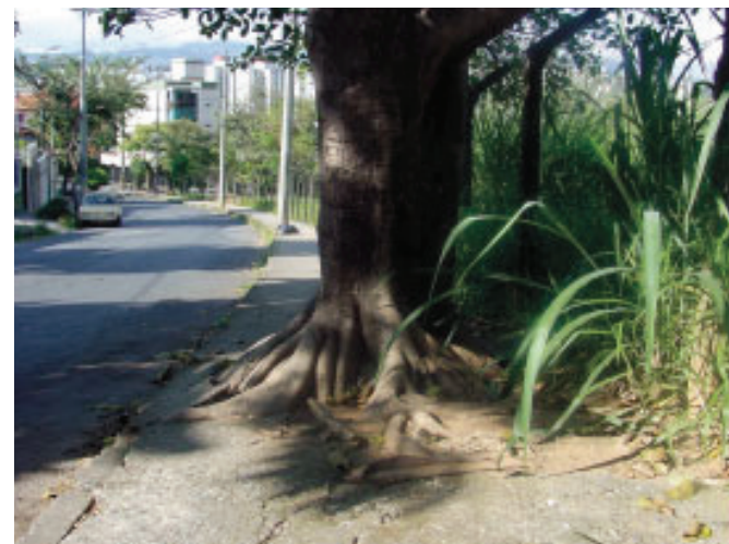
Foto 16 - Raízes de árvores danificando a calçada.
