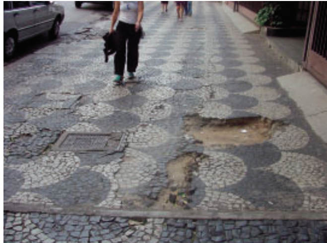
Foto 6 - Calçada sem manutenção no piso. Os buracos dificultam o livre deslocamento de pessoas, principalmente, com deficiência ou mobilidade reduzida, podendo inclusive provocar acidentes.
