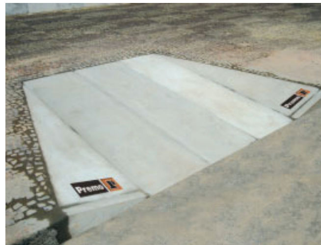
Foto A - Guia rebaixada para vaga reservada de estacionamento
