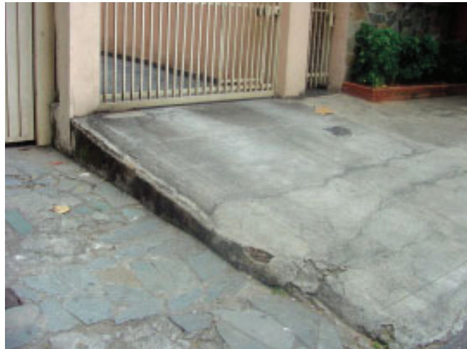
Foto 10 - Rampa de garagem fora da área do lote obstruindo a circulação na calçada.
