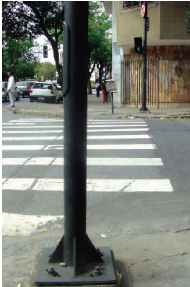
Foto 27 - Placa e poste na faixa de travessia de pedestres.
