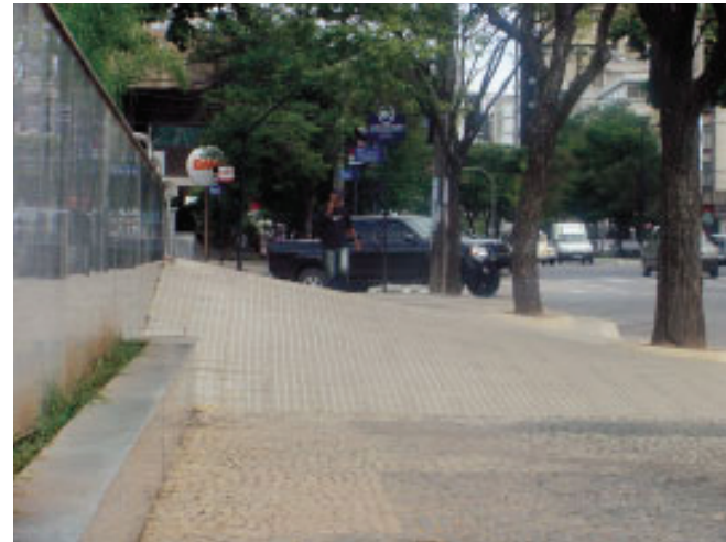
Foto 9 - Calçada com inclinação acentuada, dificultando a locomoção.
