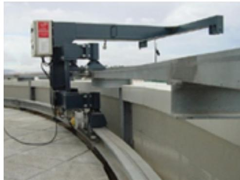
Foto: Sergio Antônio - Equipamento móvel para suspensão de andaime sobre trilhos no topo da edificação
