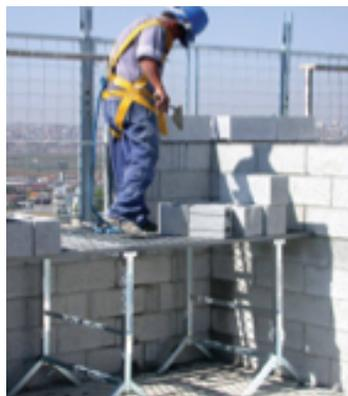
Foto: SCANMETAL – Guarda-corpo de metal
