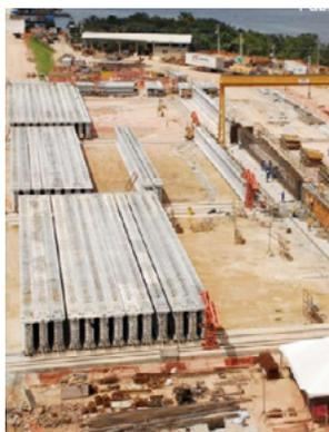
Fig.: CAMARGO CORREA - Pátio de fabricação das longarinas
