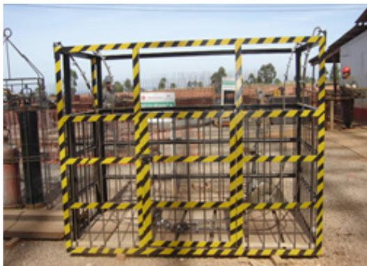
Foto: Manual NR 35 - Cesto especialmente construído para operação de resgate em altura, disponível no canteiro
