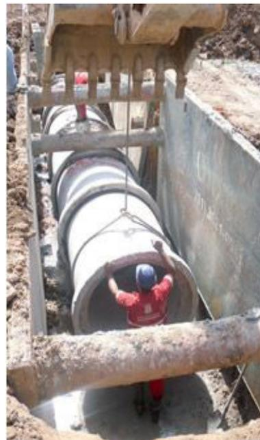
Fotos: PINI - Estroncas para travamento das chapas de aço utilizadas em módulos de blindagem de valas podem ser estáticas ou pneumáticas e ajustáveis.
