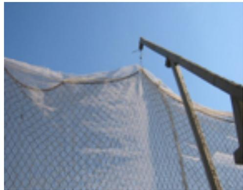
Rede tipo força (direita) e detalhe da rede (esquerda).
